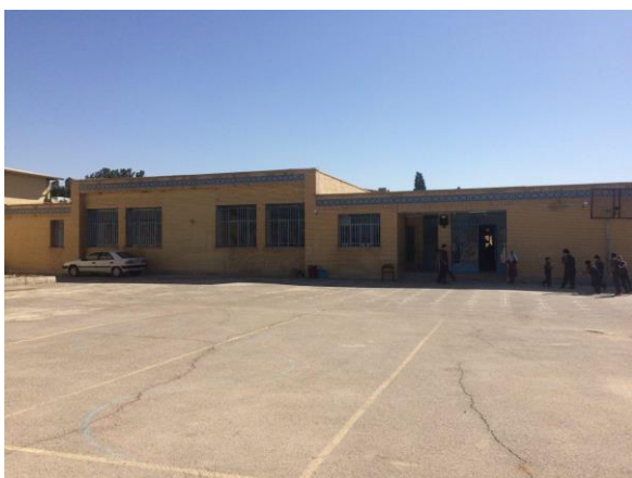
شکل ۶. وضعیت نامناسب طراحی فضای باز در دبستان ناشنویان در شهر اصفهان (مرکز شماره ۱)
